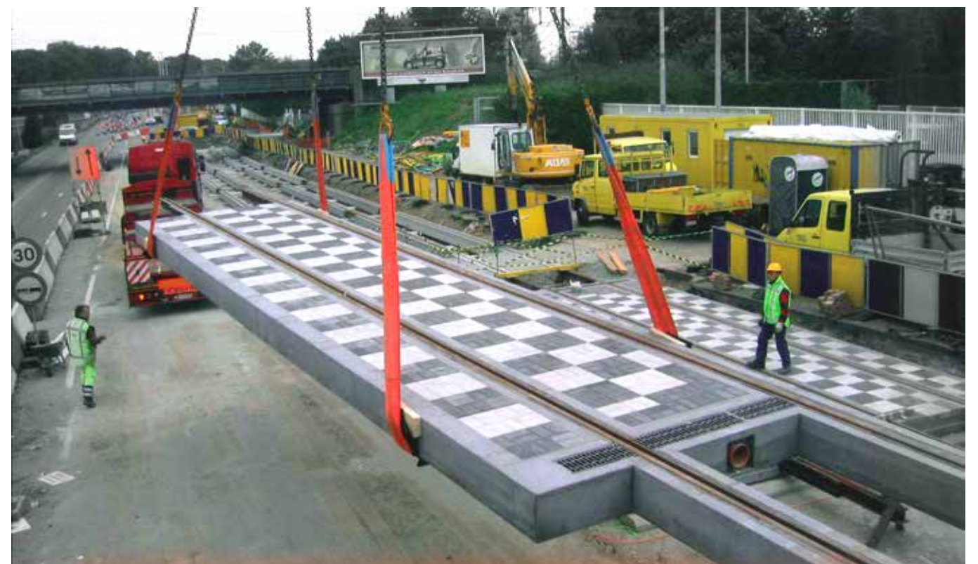
Door de overname van Prefarails is De Bonte nu ook marktleider in de productie van trambusbanen met specifieke trillingsdempende eigenschappen.
