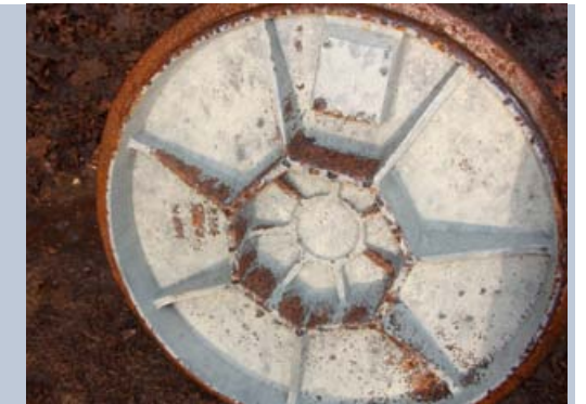
Afbeelding 4: Zwavelneerslag op nodular gietijzeren deksel, zes maanden na plaatsing
